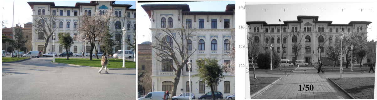
Şekil 3: Bina Cephesi, Düşeye Çevrilmiş Görüntüden Örnekler
